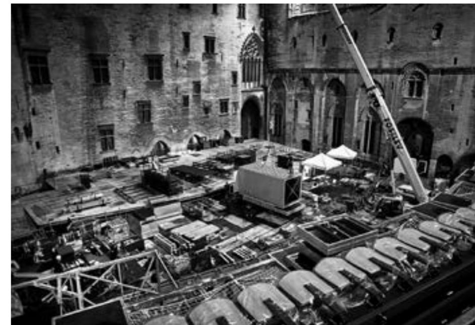
Installation de la scène et des gradins dans la sixième cour
